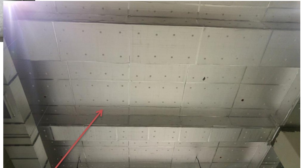
천장 건식시공(마곡 LG사이언스파크)/광명 이케아 : 단열재 노출 시공 접착 Tape 처리
